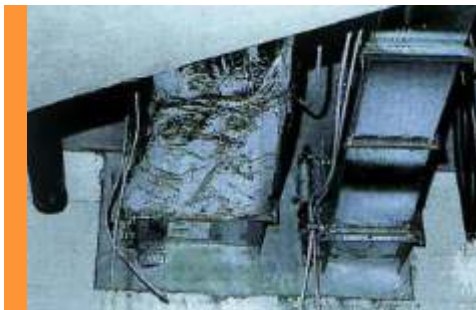
brtvljenje protupožarnog poklopca u masivnom zidu
