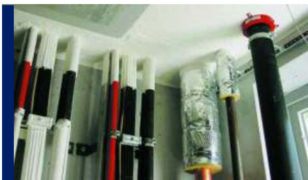
PYRO-SAFE Univerzalna pregrada COMBI S90 kao stropna panelska brtva
