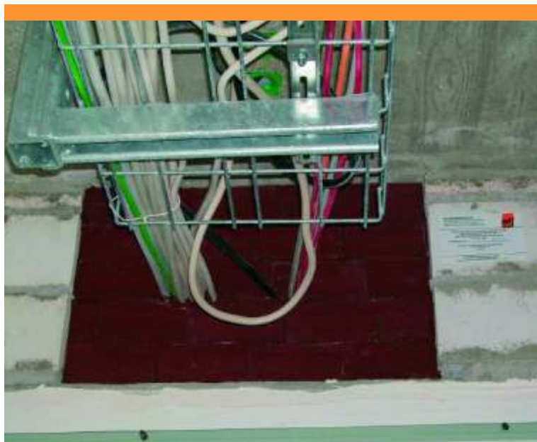
PYRO-SAFE Blok pregrada COMBI 170 S90
