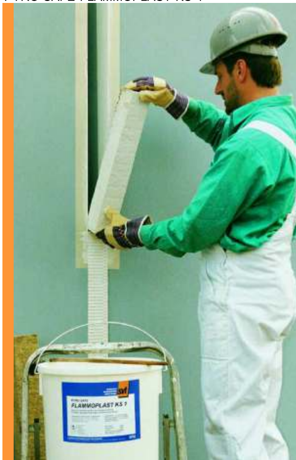
Instaliranje PYRO-SAFE Joint Sealings u građevnu vezivnu komponentu
